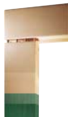
Eckverbindung mit acht Dübeln und unsichtbarer Verleimung
